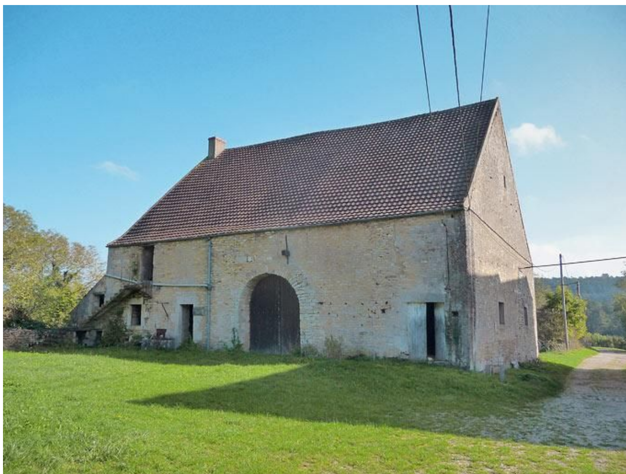
Façade de la grange.
