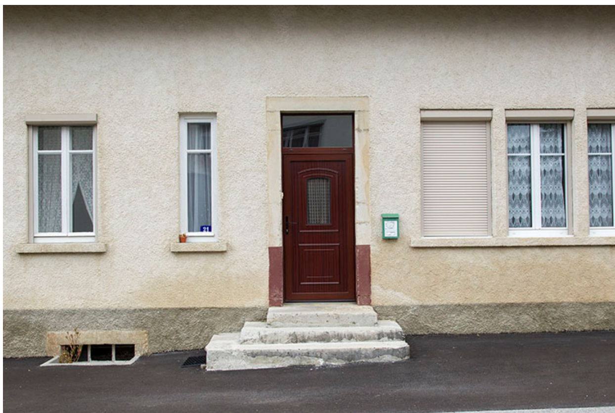
Façade antérieure : porte et fenêtres multiples.
