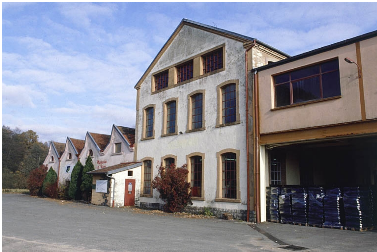
Façades antérieures depuis le sud.
