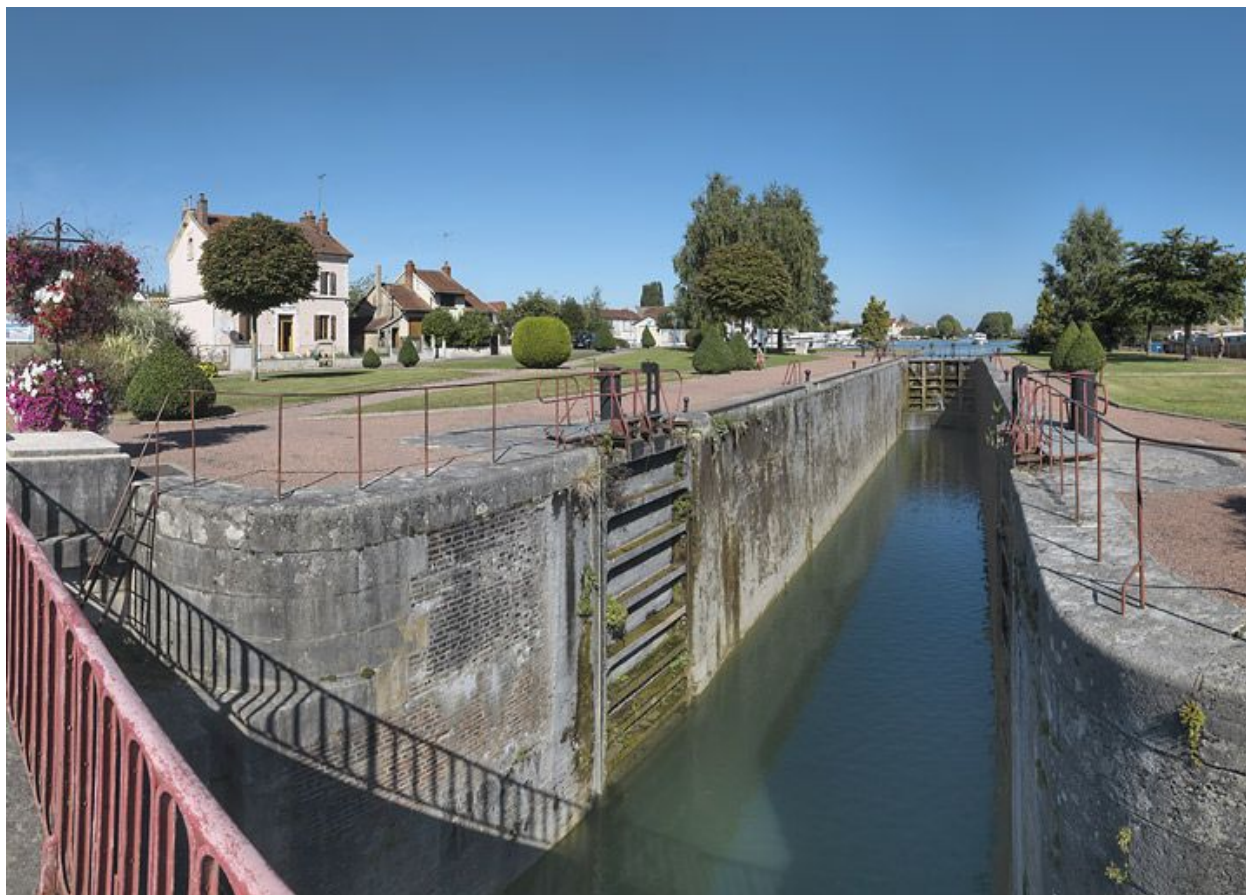
Site d'écluse vu d'amont : portes et bajoyers.
