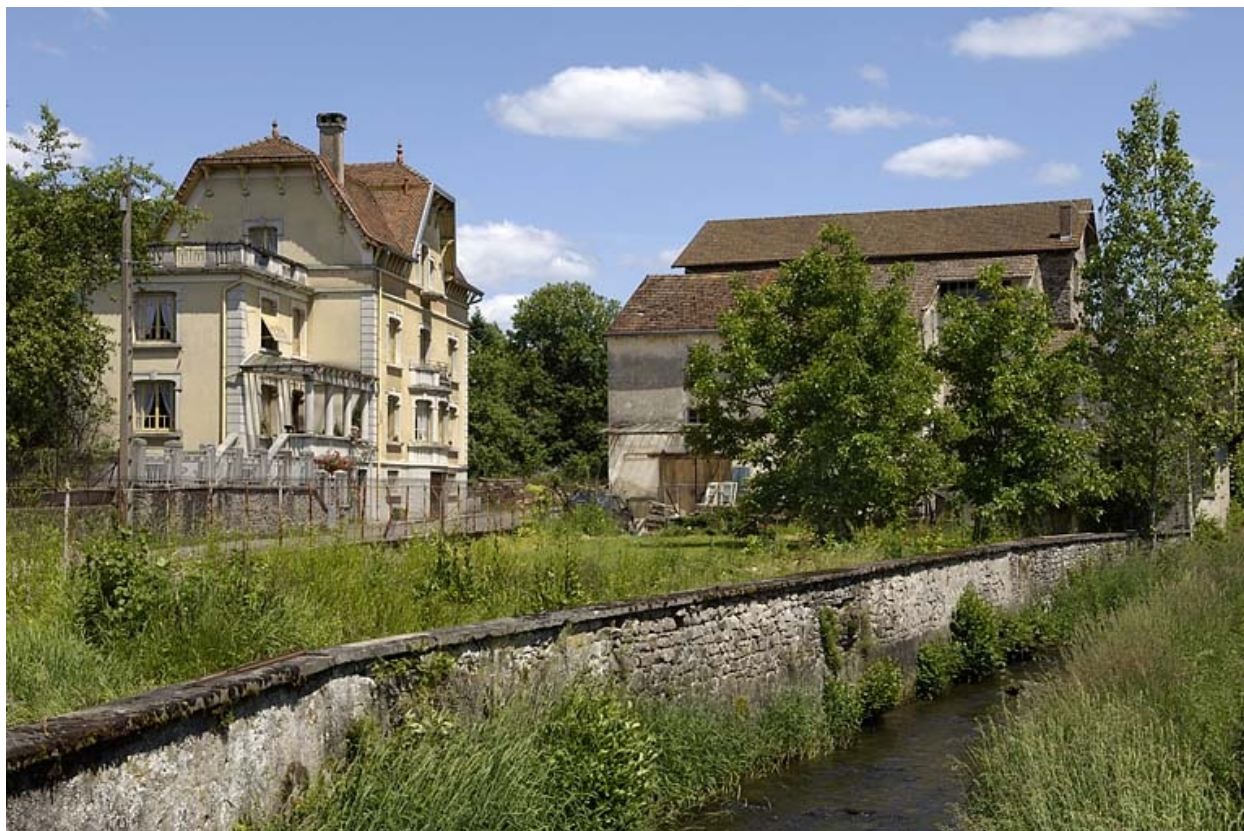
Vue d'ensemble depuis le sud.
