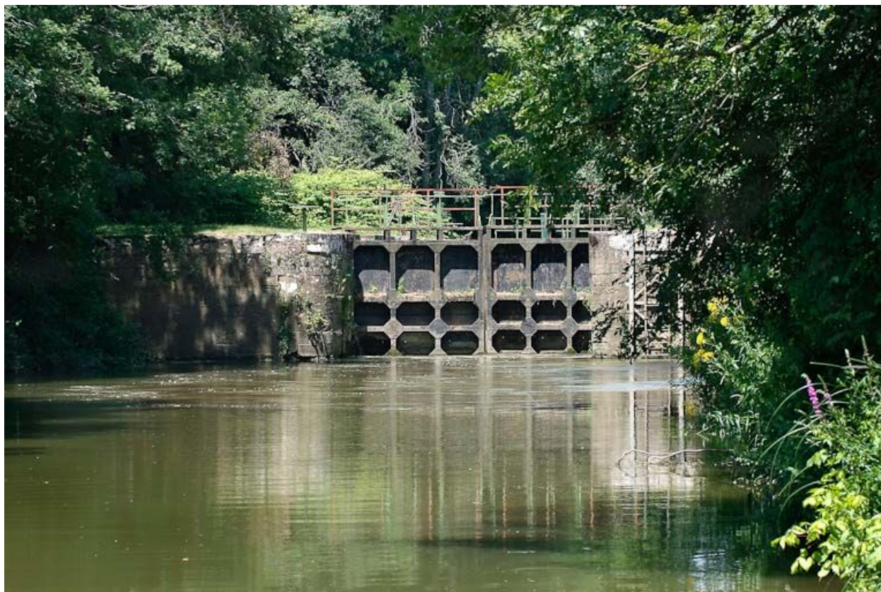
Le sas de l'écluse, vu d'aval.
