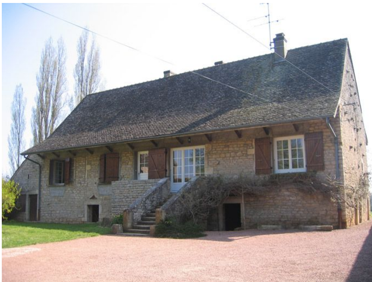
Vue d'ensemble de la façade.
