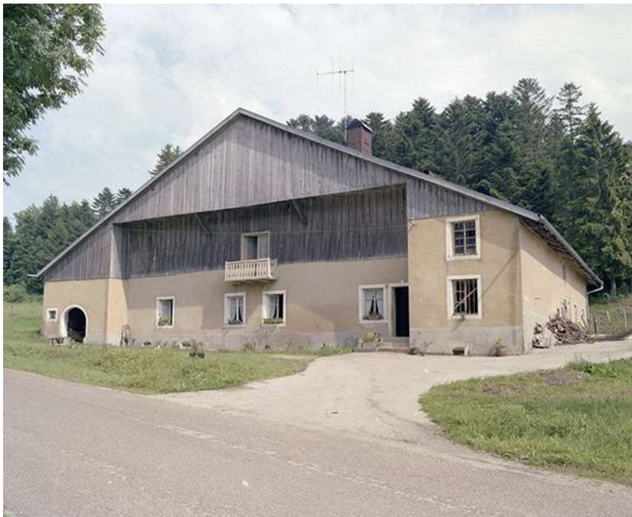
Façades antérieure et latérale droite.
