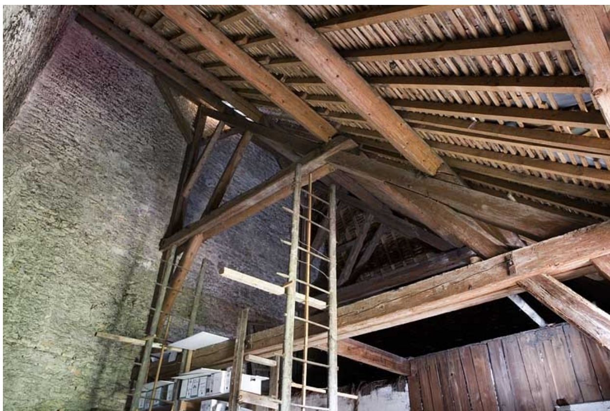
Vue du grenier à foin sur l'écurie.
