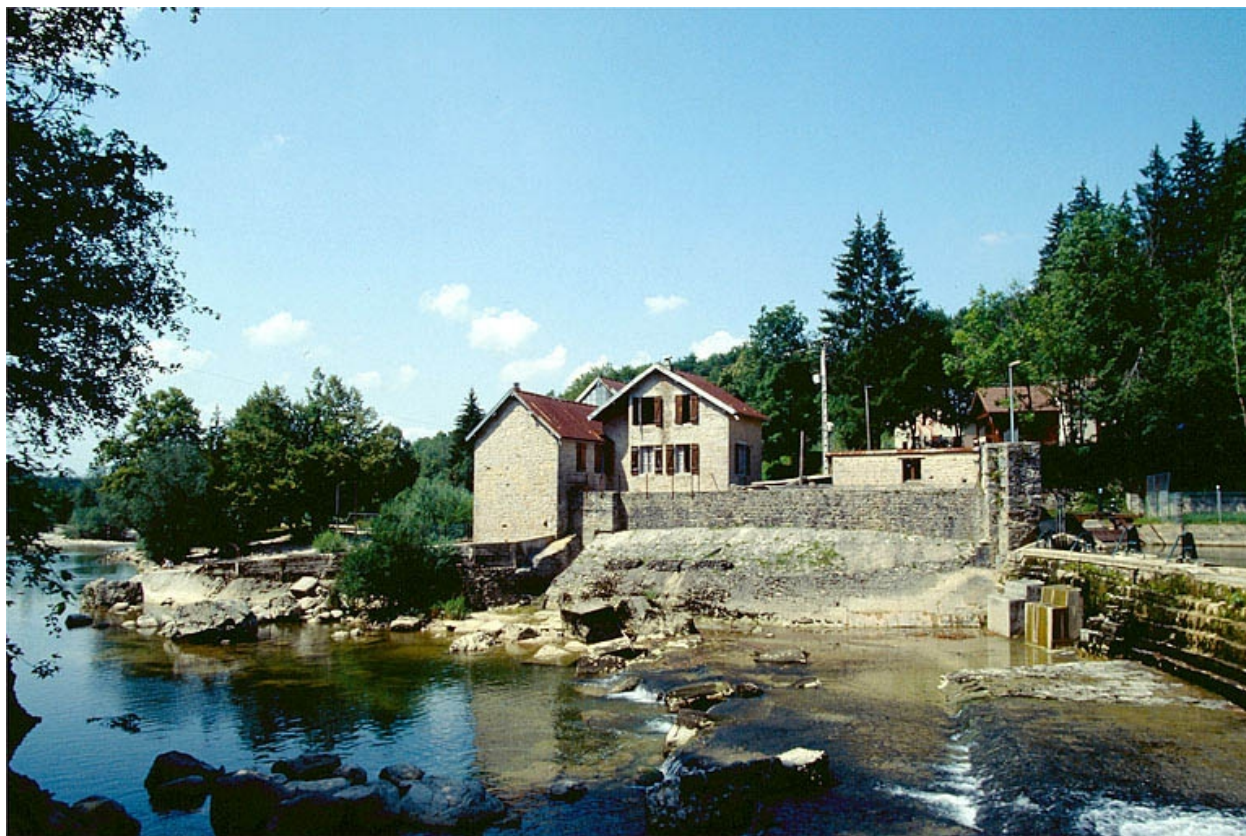
Centrale hydroélectrique de la Roche, Champagnole.
