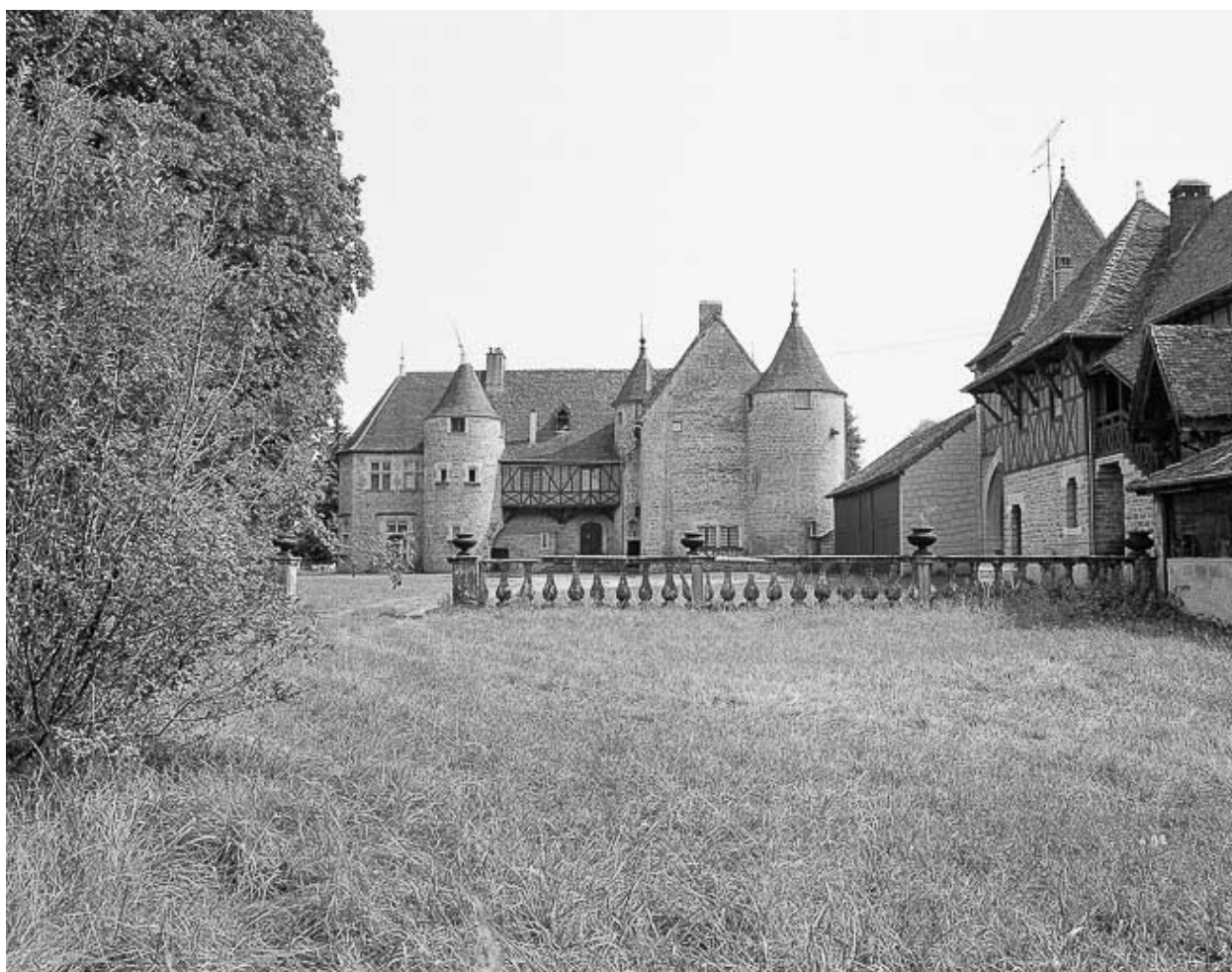
Vue générale depuis l'est
