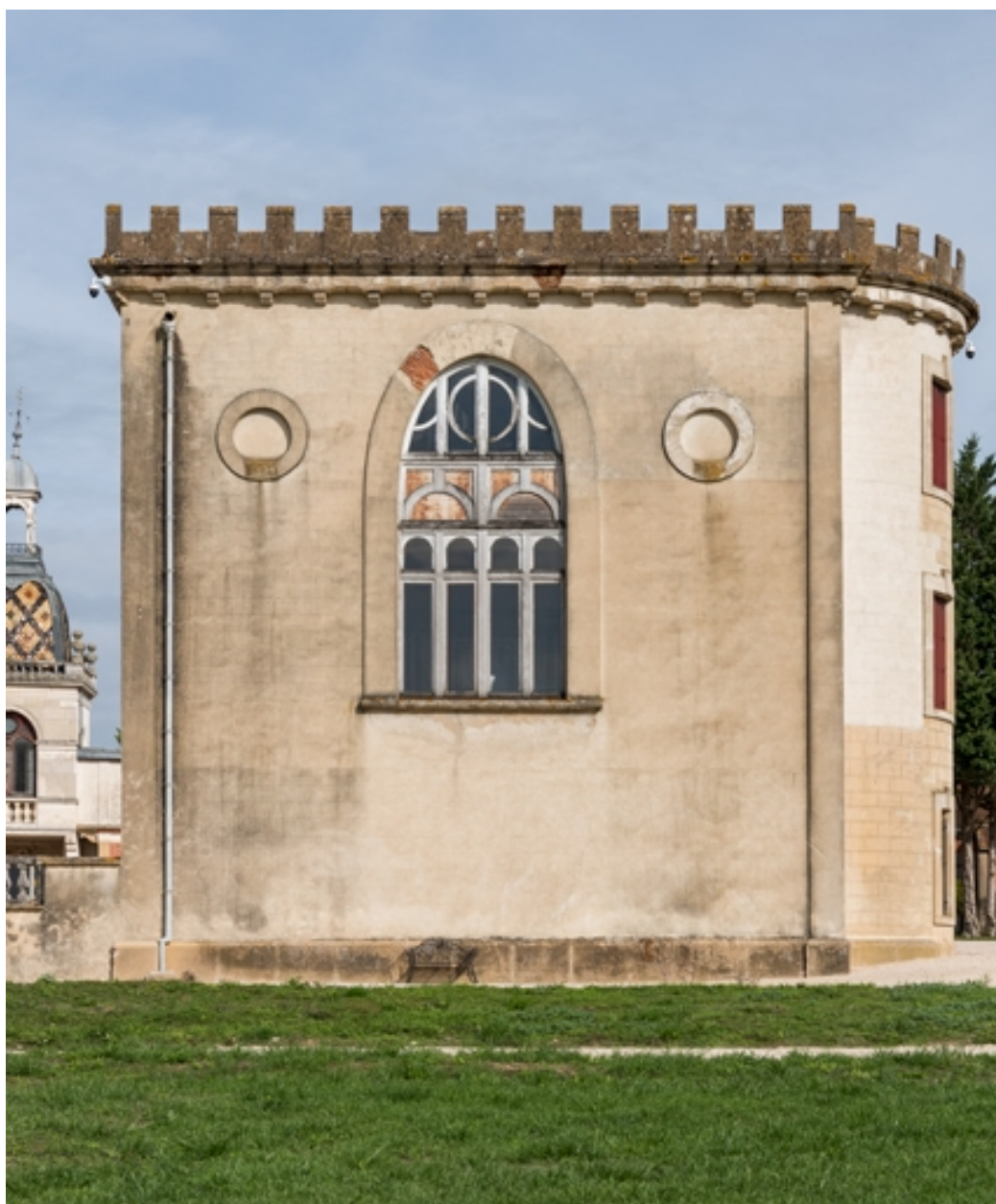
Elévation latérale droite (corps sud).
