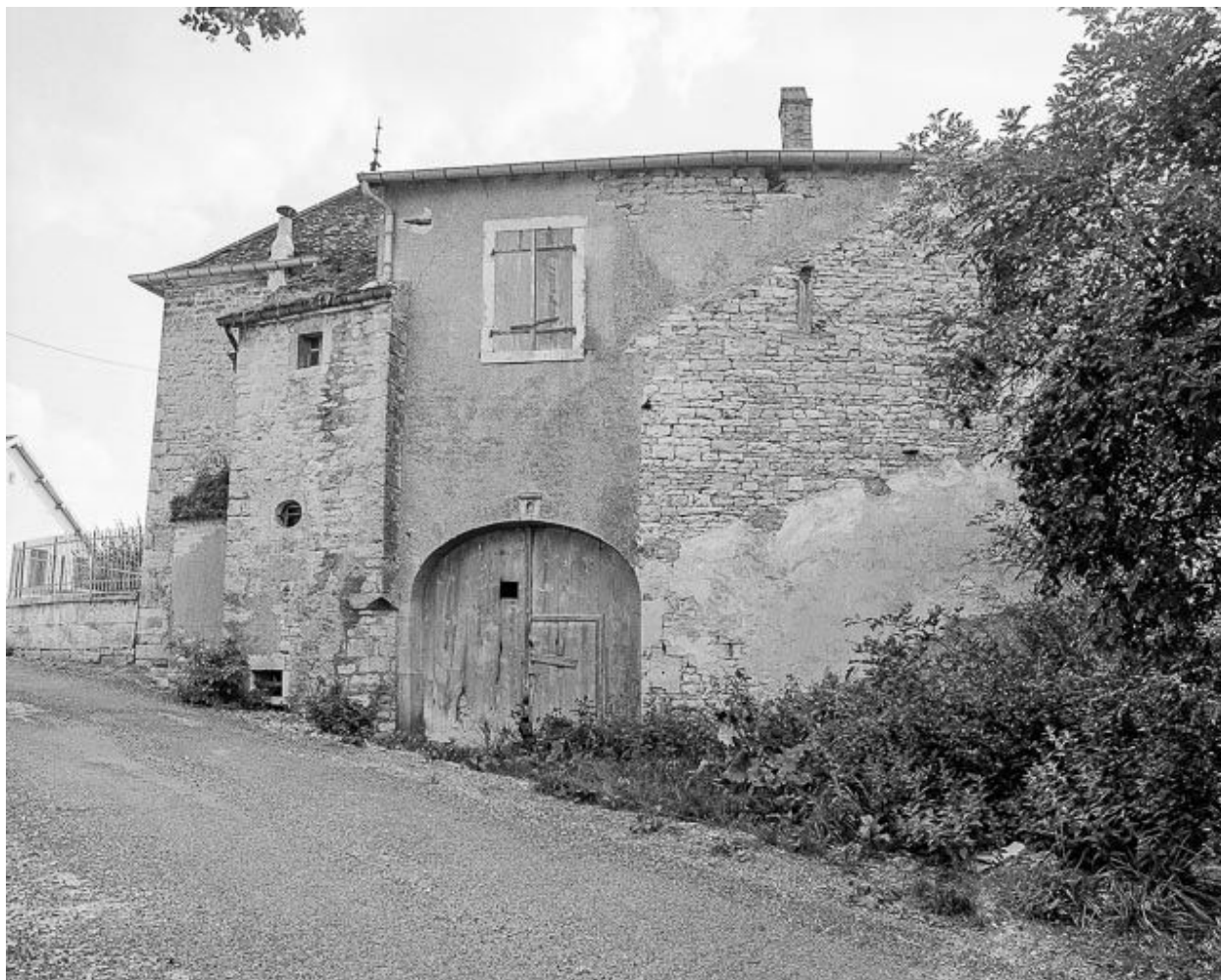
Vue rapprochée de la façade latérale droite.
