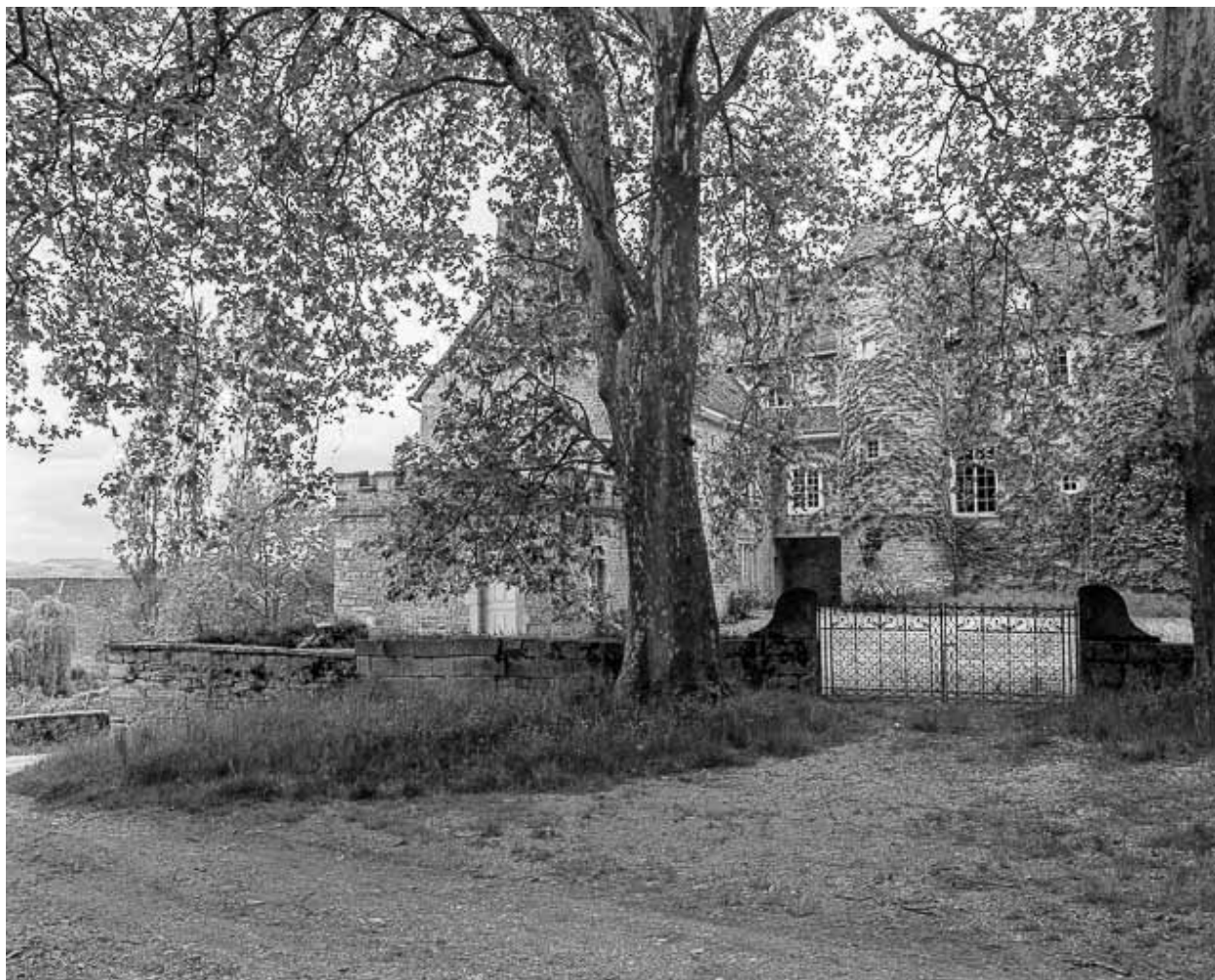
Façade sur cour et portail d'entrée.
