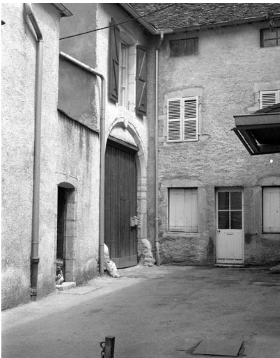
Façade latérale droite : la porte cochère.
