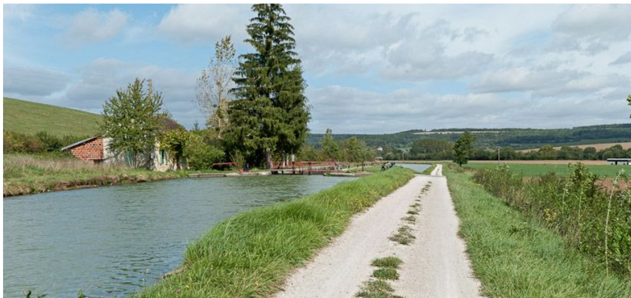
Vue du site d'écluse depuis l'amont.
