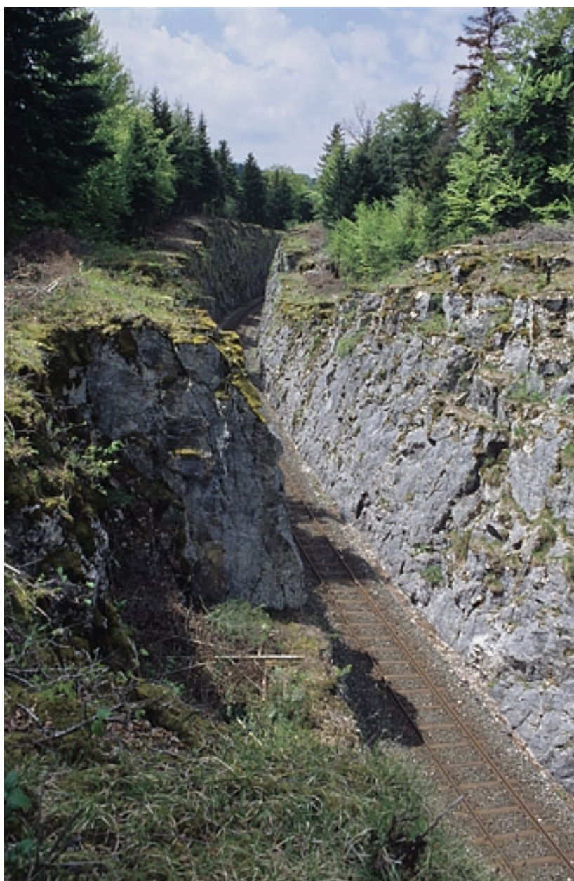
Tranchée côté Andelot-en-Montagne, vue du pont.
