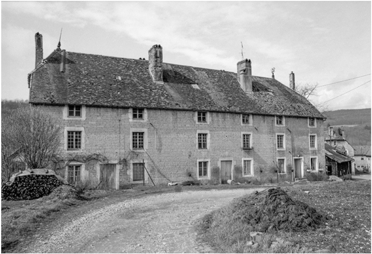
Logement ouvrier. Façade antérieure (est) en 1979.
