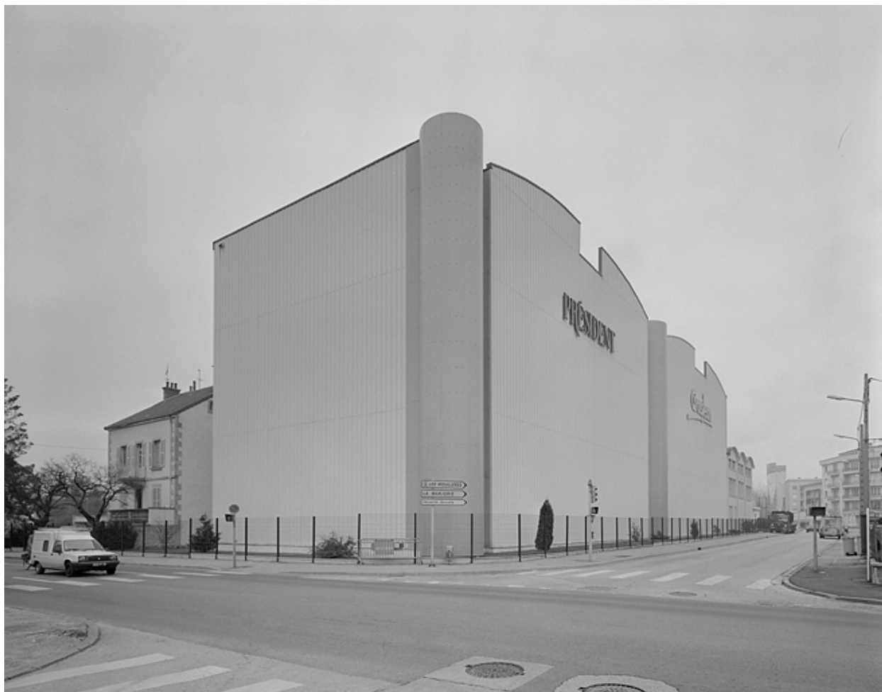
Magasin et entrepôt industriels.
