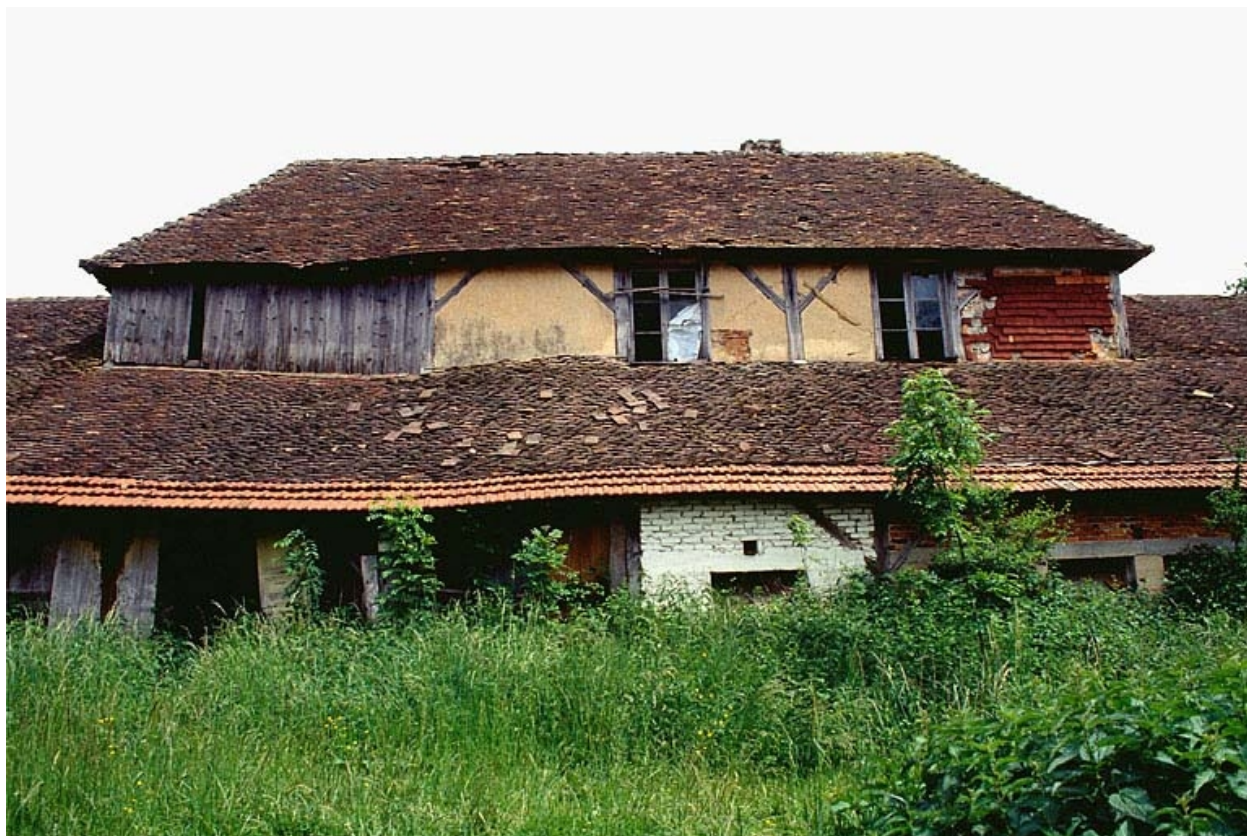
Façade ouest du logement d'ouvriers.
