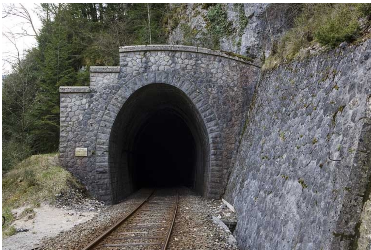
Tunnel : tête côté Andelot-en-Montagne (nord).
