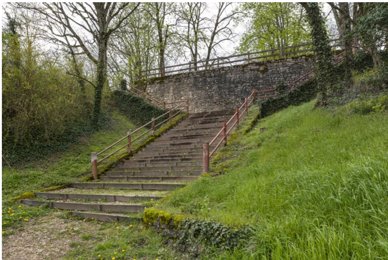
Escalier et mur de soutènement.
