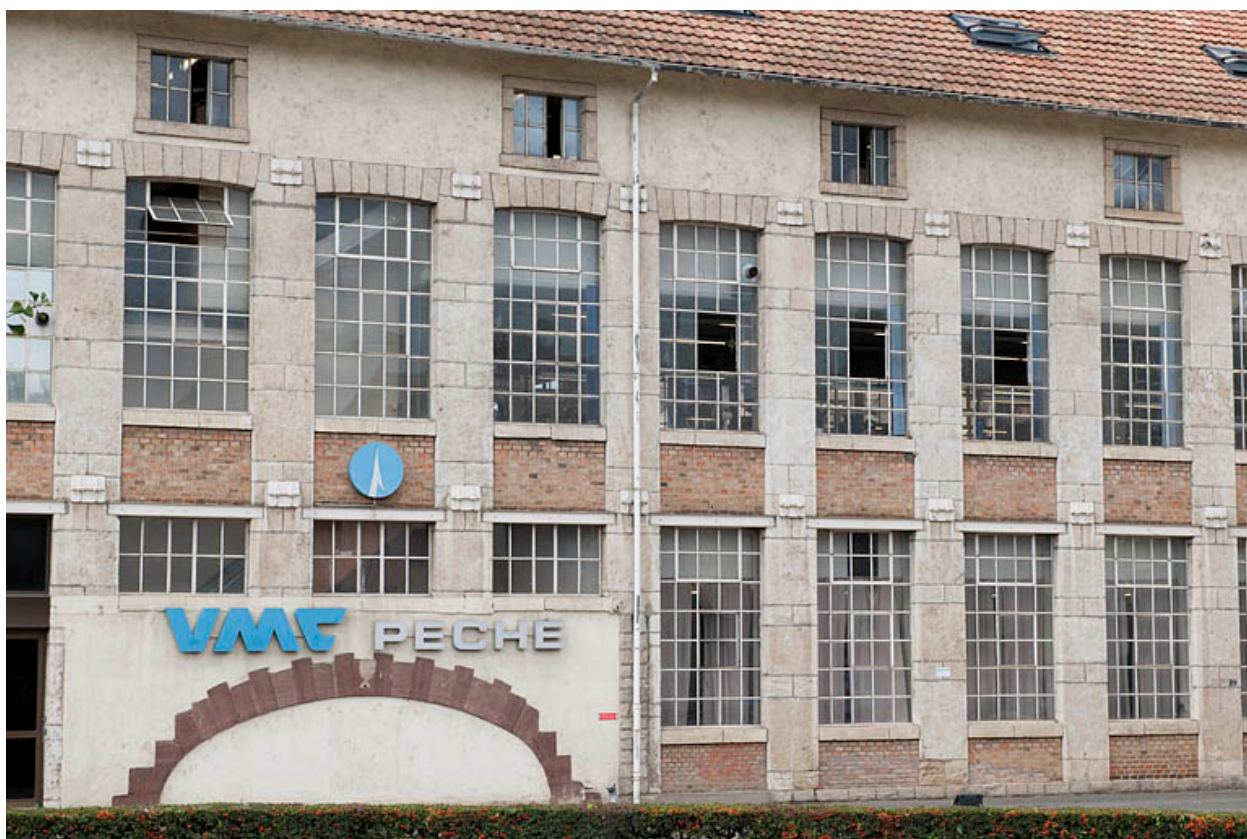
Détail de travées de la façade antérieure.
