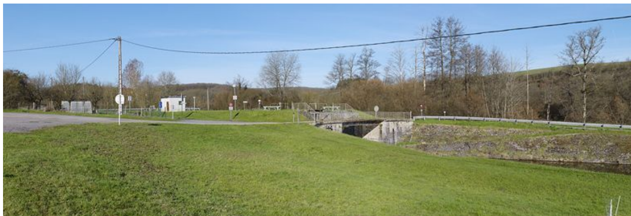
Vue d'ensemble du site d'écluse.
