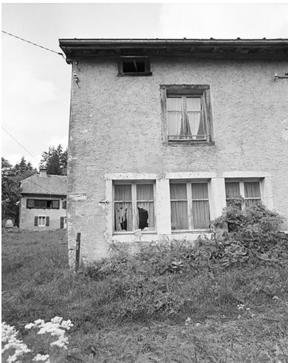
Les fenêtres de l'atelier.
