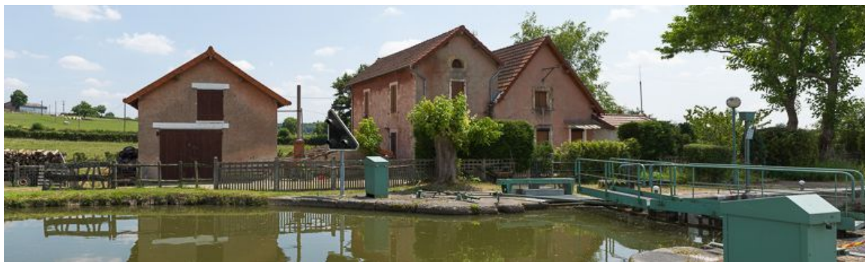
Vue d'ensemble du site atypique.
