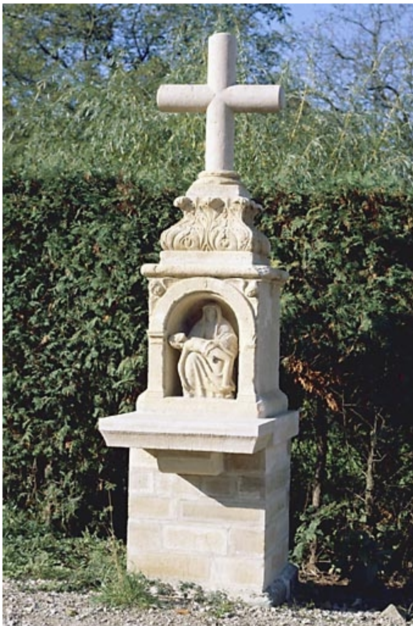
Vue de face après restauration.
