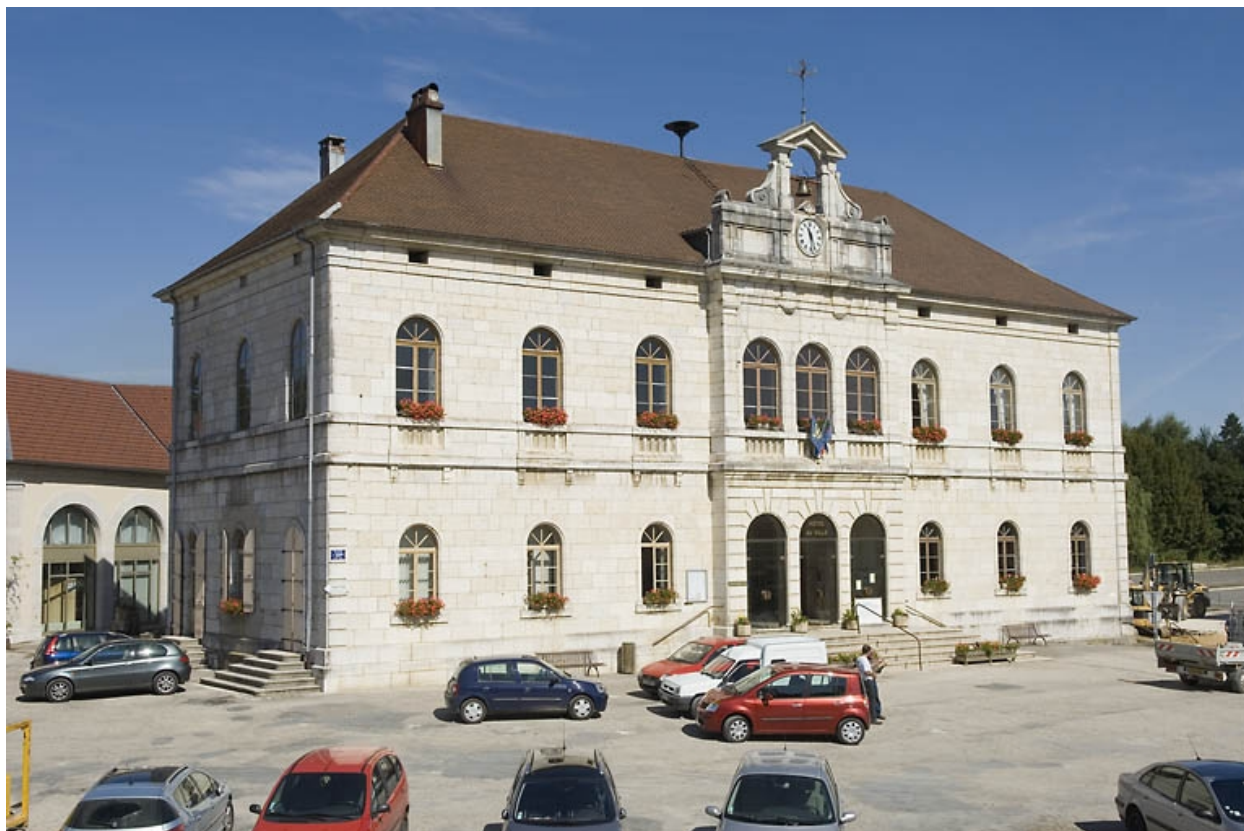
Façade antérieure en 2008 : vue de trois quarts gauche.
