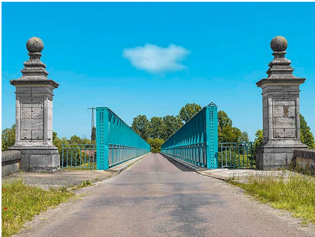
Entrée du pont.
