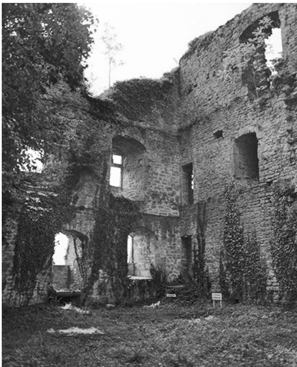
Le donjon, vue intérieure de l'angle sud-est.
