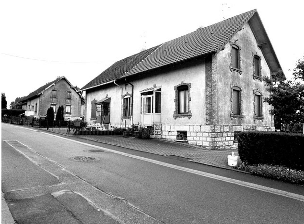
Logement double dans la 3e rue.
