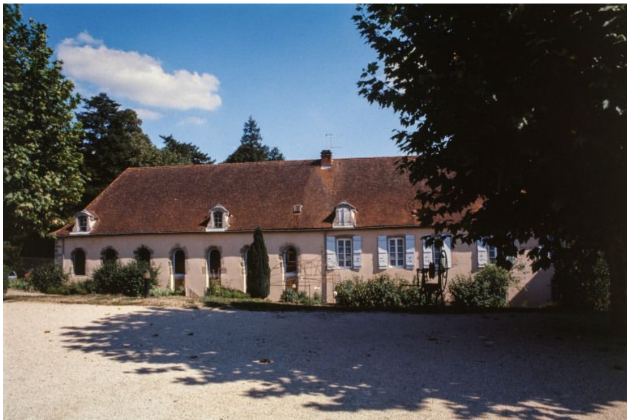
Vue générale de l'ancien hôpital, façade postérieure.
