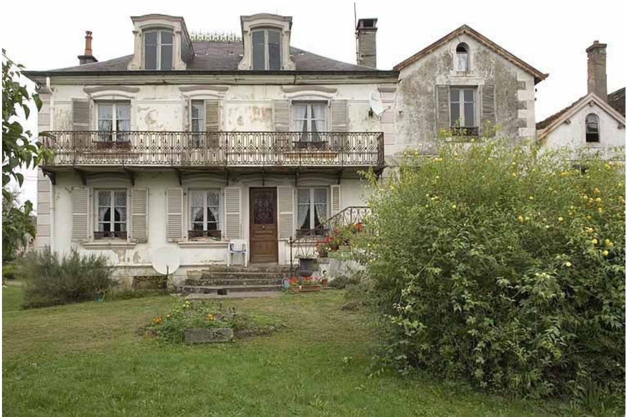
Logement patronal. Façade antérieure.
