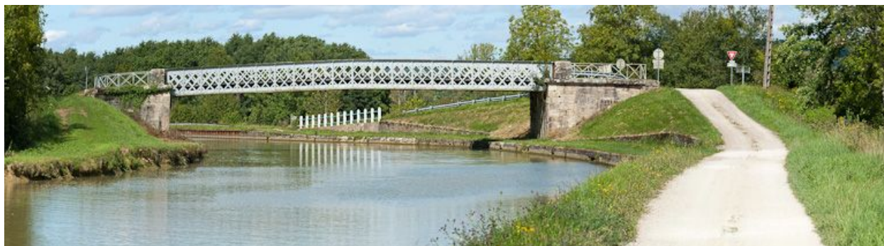
Vue du pont.
