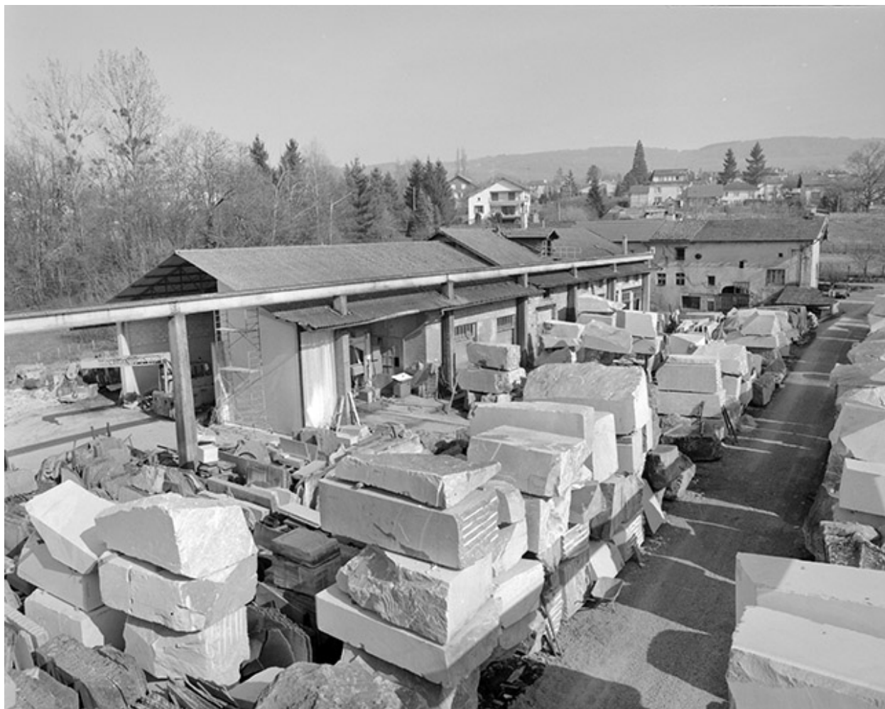
Vue d'ensemble des bâtiments depuis l'ouest.
