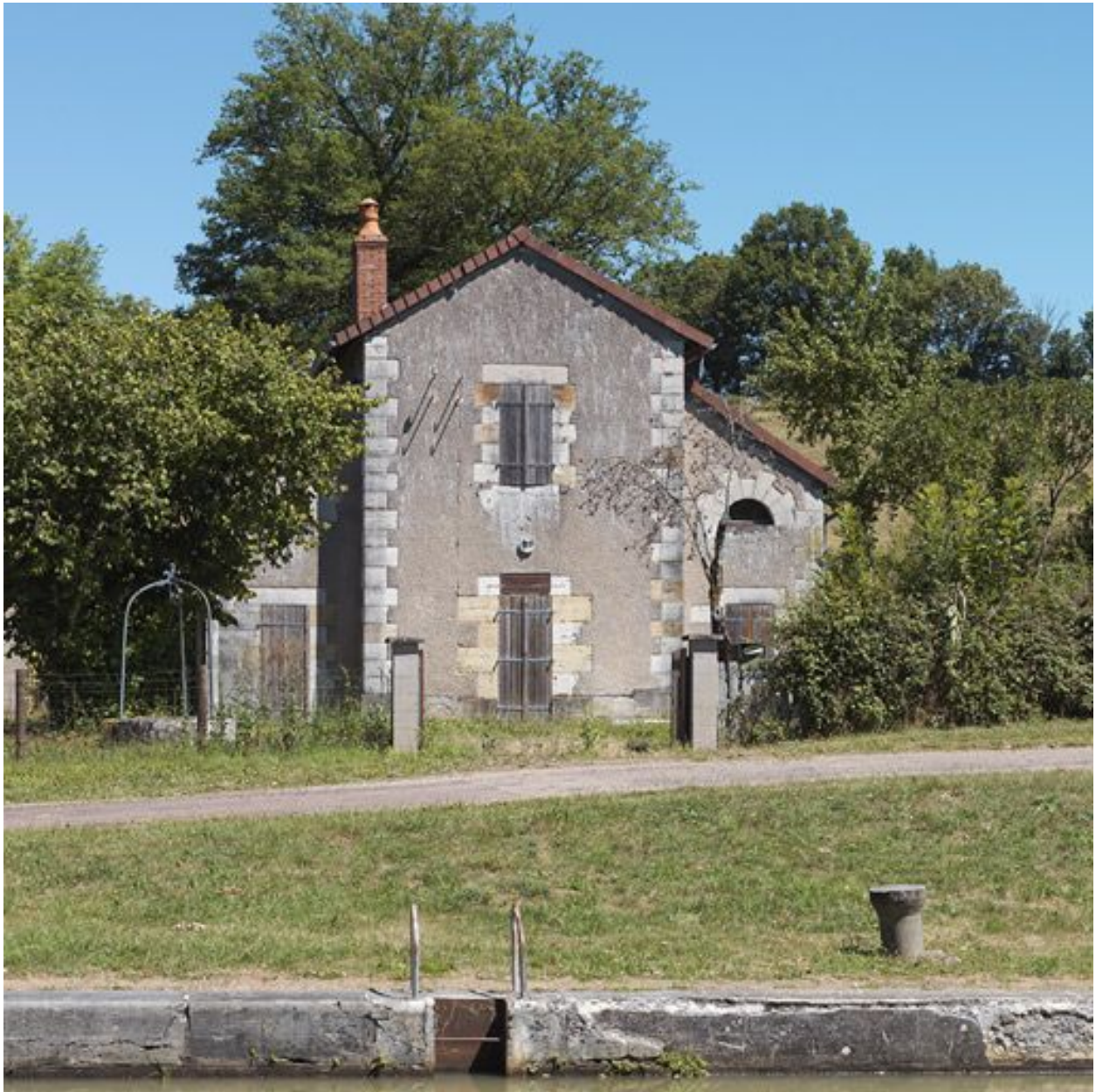
La maison éclusière de face.
