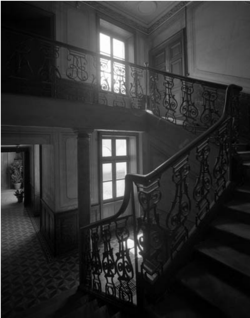
Escalier d'honneur : vue d'ensemble.
