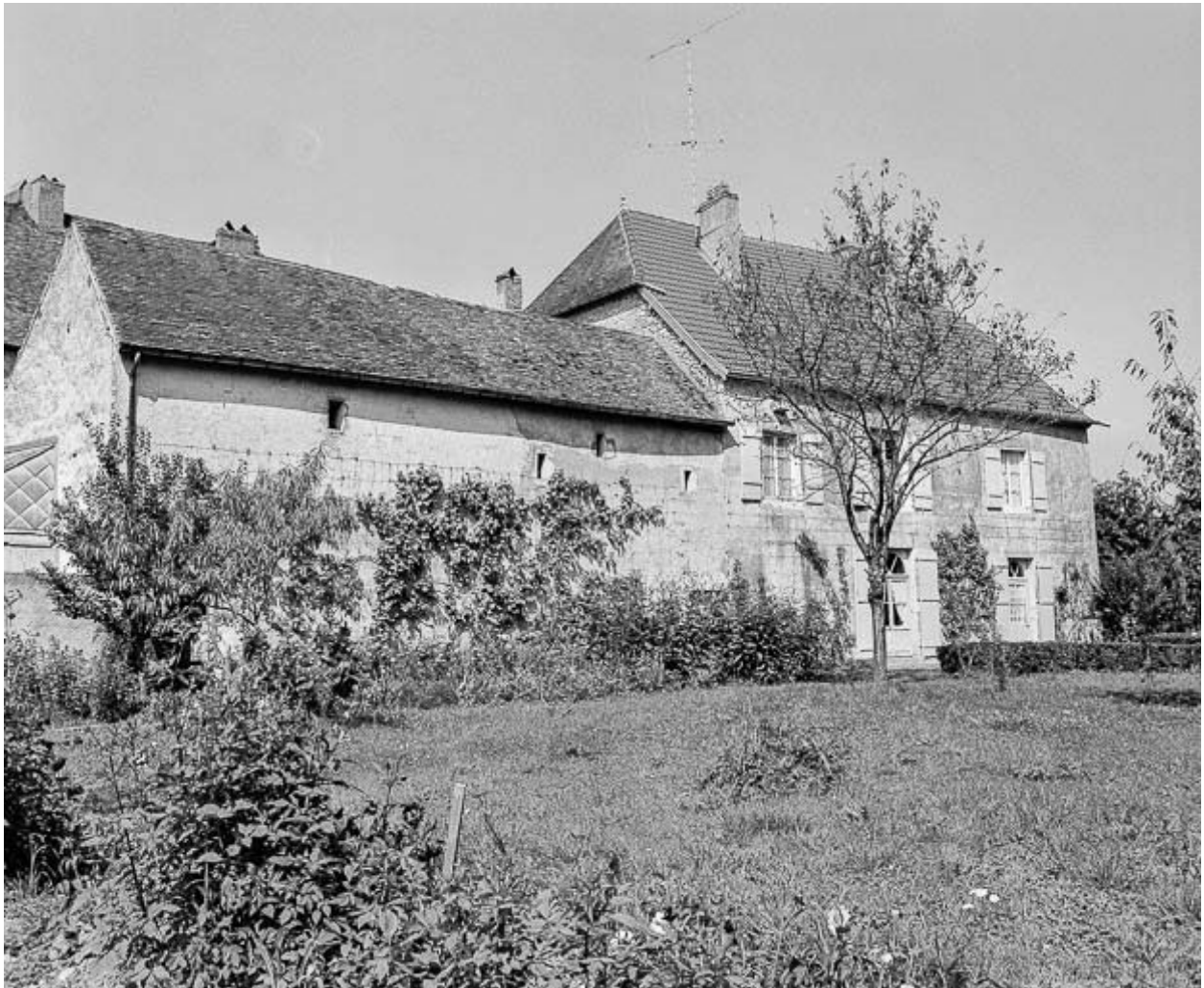
Façades postérieures de l'habitation et des communs.
