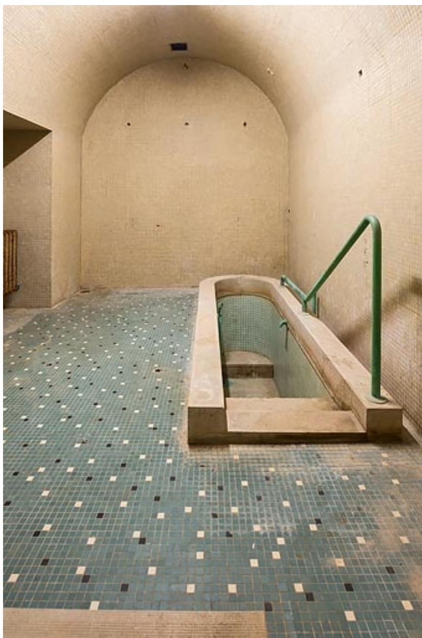
Ancienne cabine de bain, au rez-de-chaussée.
