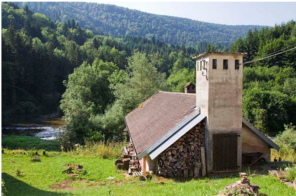
Centrale : façade latérale droite et transformateur.
