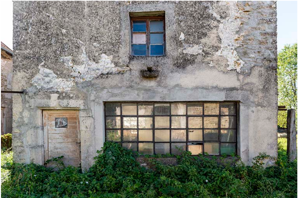
Forge, façade antérieure : porte et fenêtres.
