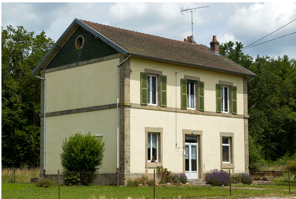
Ancienne gare, 30 rue de la filature.
