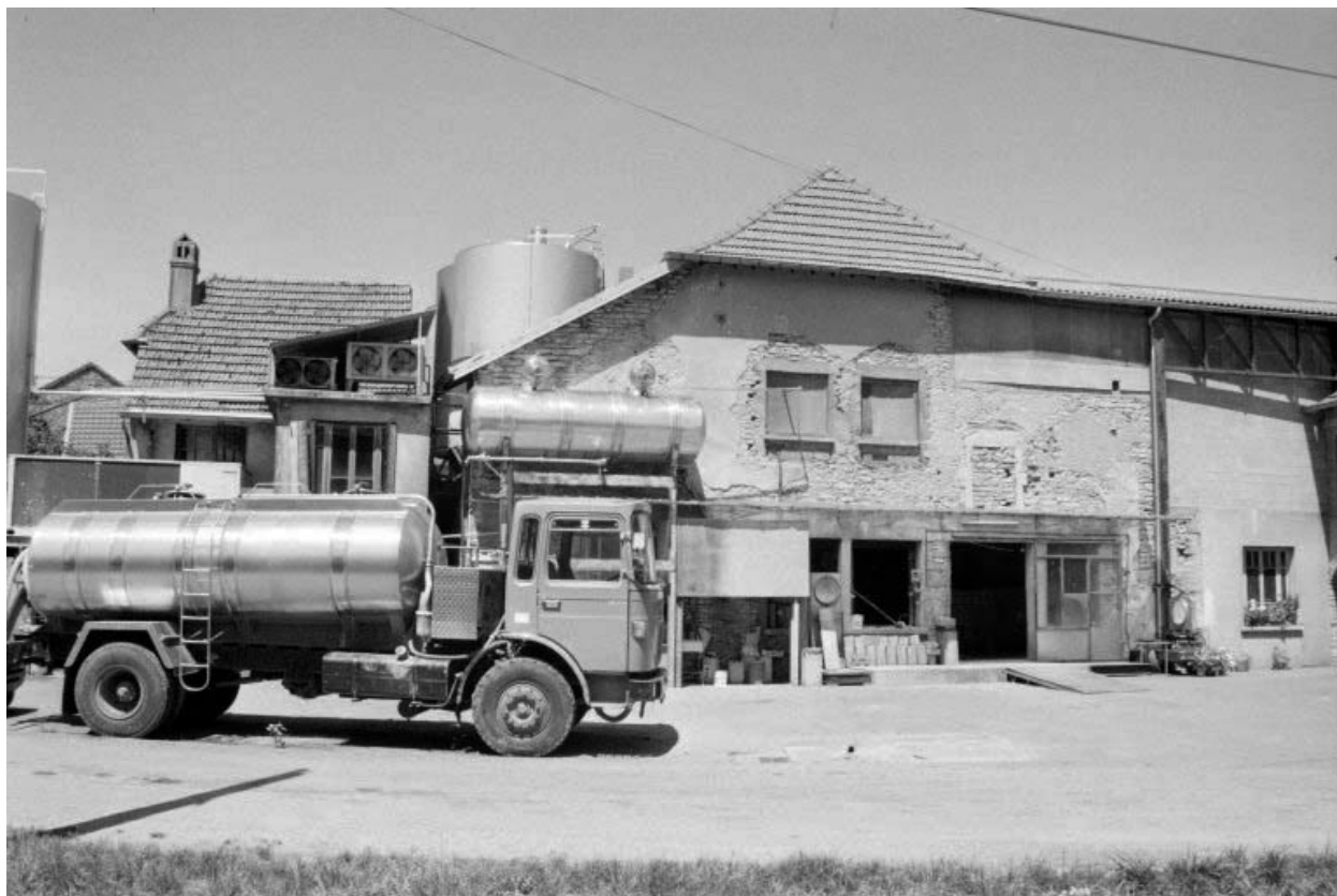
Façade antérieure de l'atelier de fabrication.
