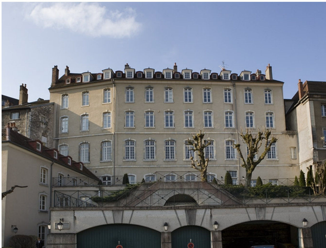
Vue d'ensemble de la façade postérieure.
