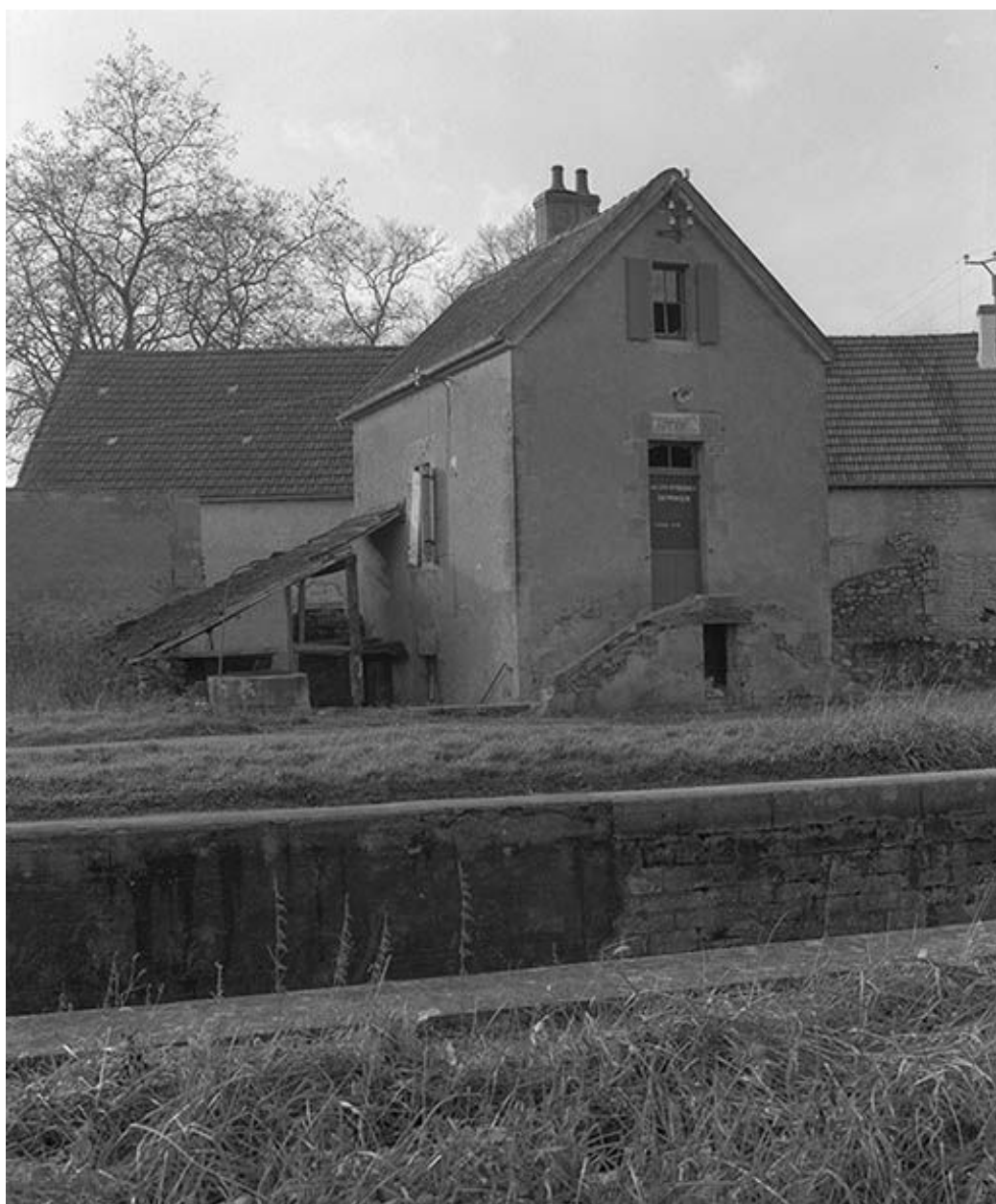
La maison d'éclusier.
