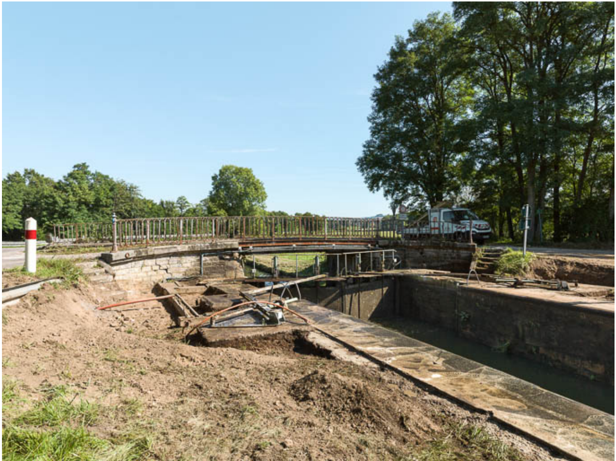
Vue d'ensemble du pont.
