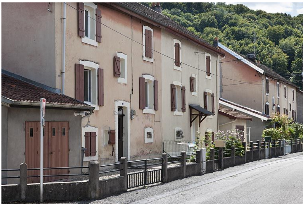
Façades antérieures vues de trois quarts.
