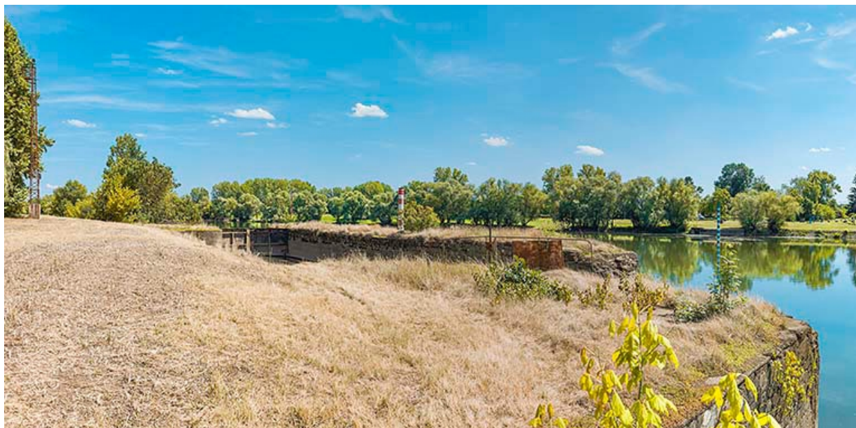
L'ancienne écluse de Verdun au premier plan.
