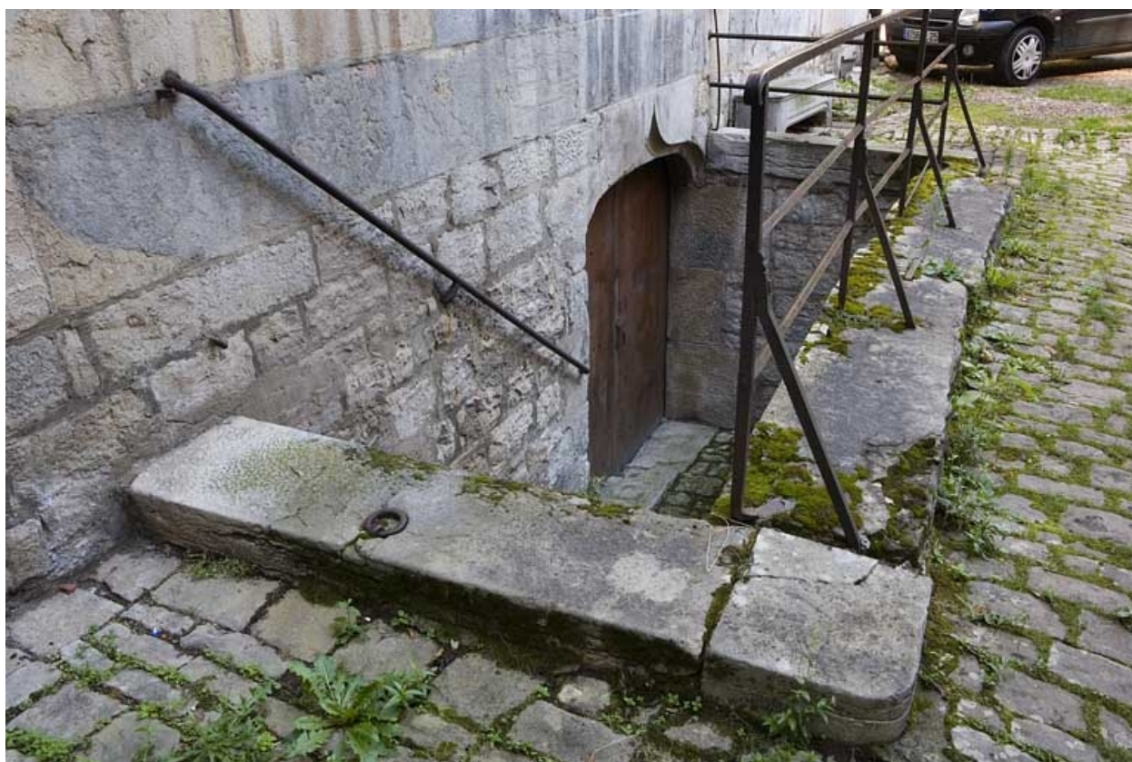
Logis principal : détail de l'entrée du sous-sol.
