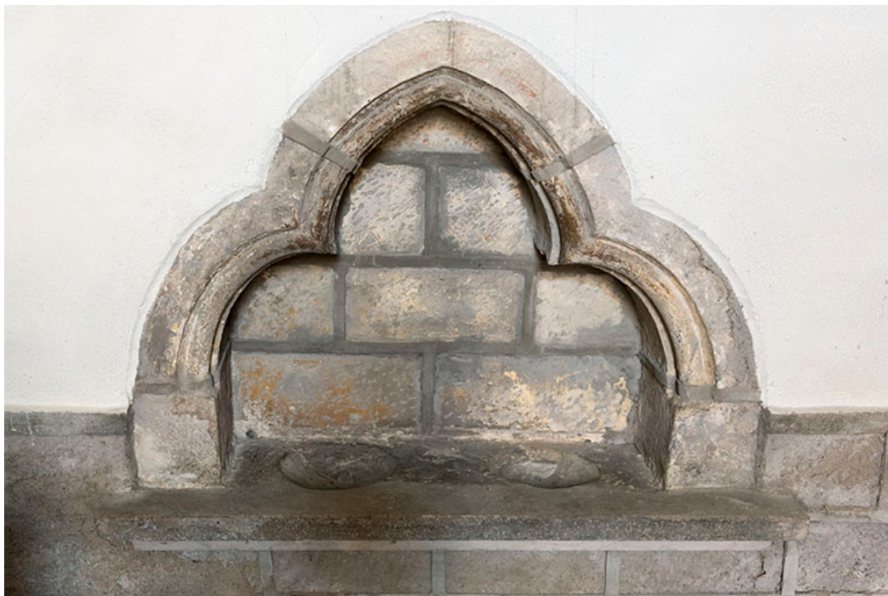
Détail : niche trilobée à droite du chœur.
